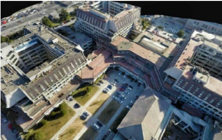
▲ 航拍图像的大规模三维重建模型
